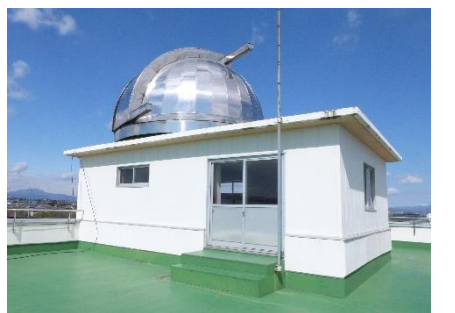
▲屋上東側にある天体観測用施設
